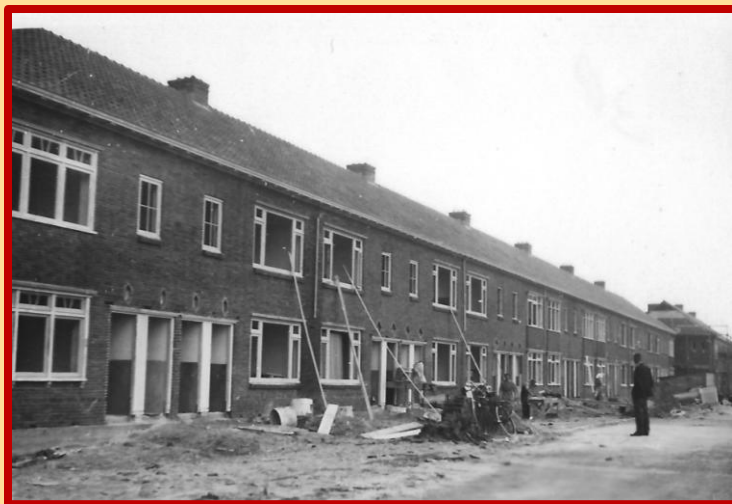
Bouwfase van de woningen in de Prinses Margrietstraat, augustus 1950
