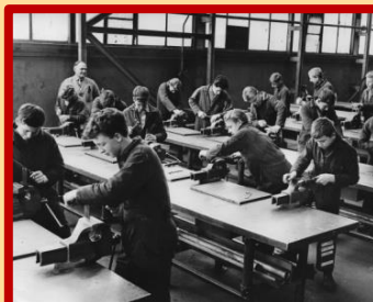
Leerlingen van Werkspoor's Leerschool Bank- en Plaatwerken zijn onder leiding van Leermeester Z. Lit aan het vijlen aan hun werkstuk.
