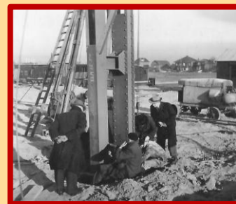
Het plaatsen van een kolom voor de hal van Smederij Noord.
