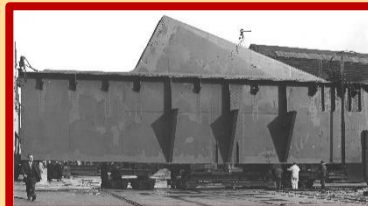
'Stukje' van de Van Brienoordbrug verlaat de fabriek van Werkspoor.
