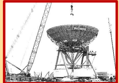
Werkspoor bouwde ook de telescoop-antenne van Dwingeloo. 'WESCON', de montagepoort van de fabriek plaatste het gevaarte.
