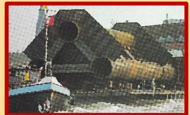
Voor boorplatforms op de Noordzee bouwde men gigantische onderdelen. (Op de achtergrond nog de St.-Ludgeruskerk aan de Amsterdamsestraatweg.)
