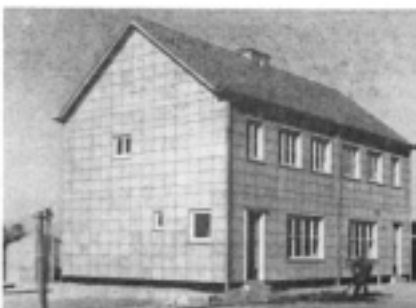
PROEFWONING BOUWSYSTEEM KLIJN, 1948
